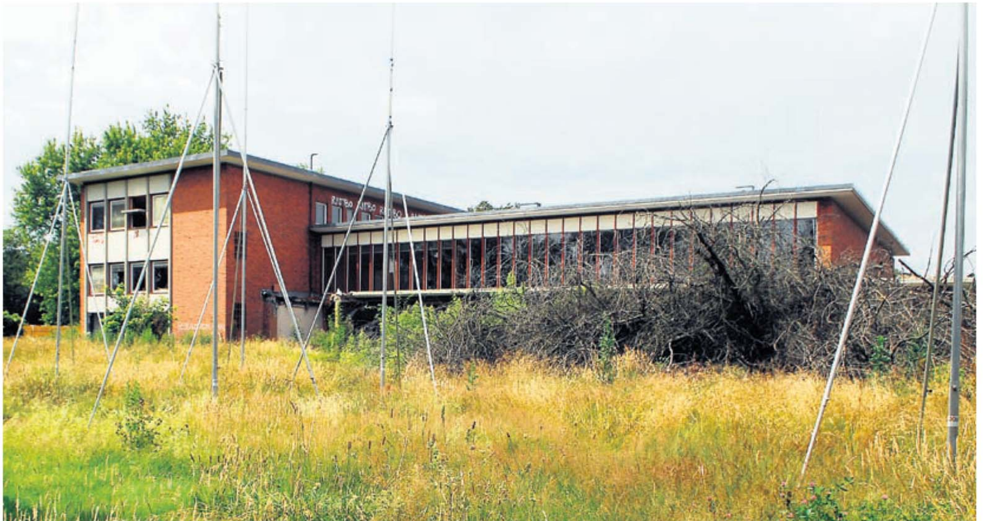
Zwei Gutachten gibt es inzwischen über die Schutzwürdigkeit des Wohlfahrtshauses in Hegi: ein kantonales und ein städtisches. Die Stadt verlässt sich auf ihr eigenes und gibt die Lizenz zum Abreissen. Bild: Marc Dahinden
