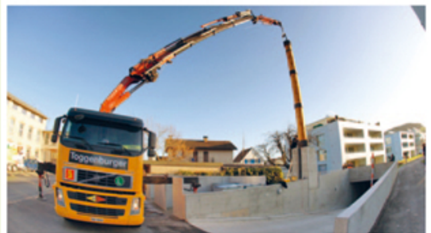
Die 13 Meter hohe und 2,5 Tonnen schwere Skulptur wird installiert.
